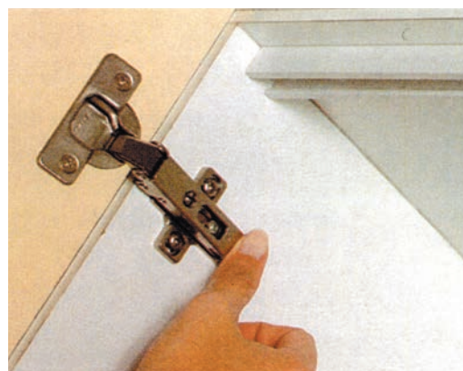
側板の座金に吊元のヒンジを取付け折戸を吊り込みます。
